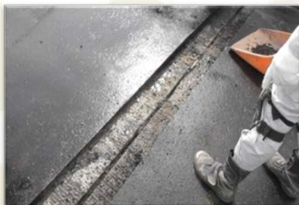
STEP1 施工前状況
