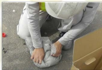
STEP3 材料の練り混ぜ
