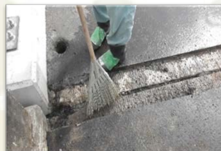
STEP2 施工面の清掃
