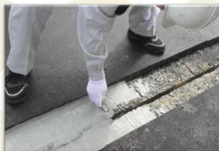
STEP5 敷き均し
