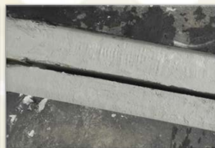
STEP6 施工完了
